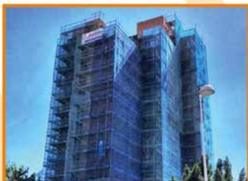
Rehabilitación Edificio SEPE en Salamanca (Ministerio de Trabajo)
