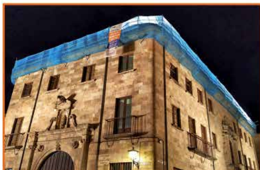
Rehabilitación Aulario de San Isidro Universidad de Salamanca (2018)
