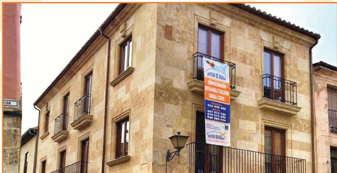
Construcción de Edificio de Viviendas y Locales Calle Libreros 58 de Salamanca (2017)
