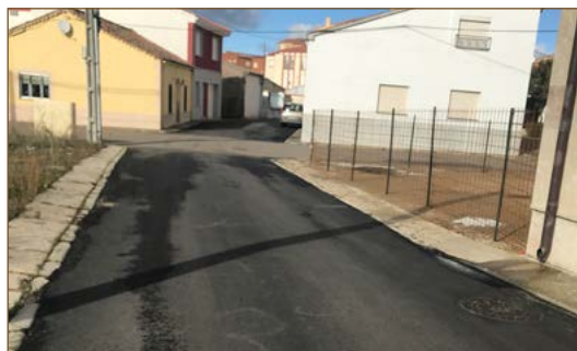
Asfaltado Calle Colón
