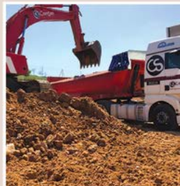
Excavaciones y Transportes
