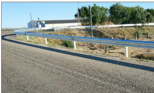
Colocación de quitamiedos
