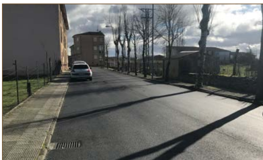
Asfaltado Calle El Rodeo
