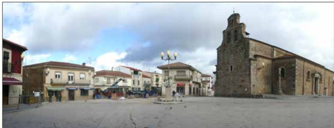
Obras remodelación Plaza Mayor
