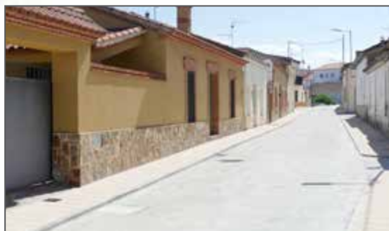
Arreglo de la Calle La Canal
