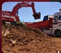
EXCAVACIONES Y TRANSPORTES
